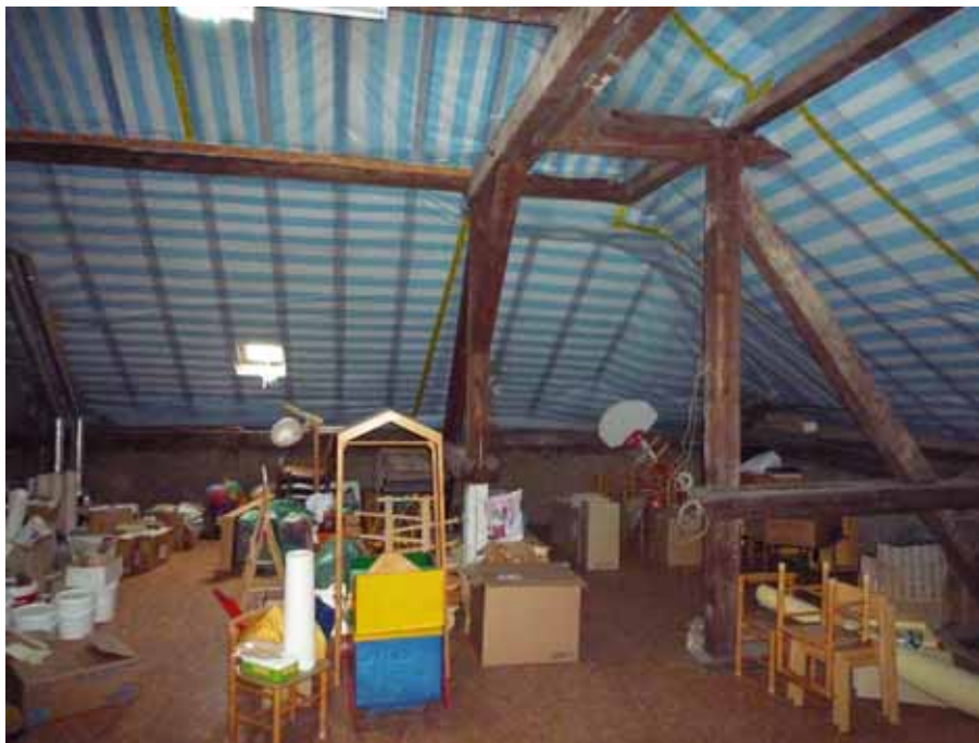
Dachgeschoss "alte Schule"
