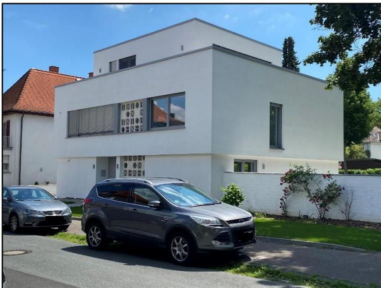
**Abbildung 25 Beispiel: Gebäude mit zwei Vollgeschossen (unter Einhaltung der TWH) mit zusätzlichem zu allen Seiten eingerücktem Staffelgeschoss**
