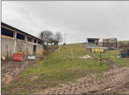
Blick hangaufwärts in westliche Richtung
