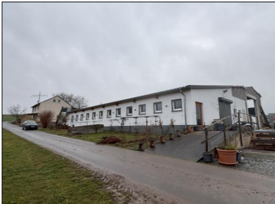
Blick auf den ehemaligen Kuhstall
