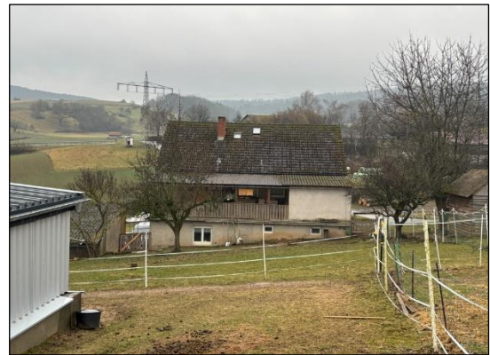
Rückwärtige Ansicht des Wohnhauses
