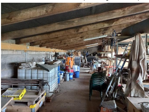
Abb. 6: Dachgeschoss in der Halle (über der Werkstatt)
