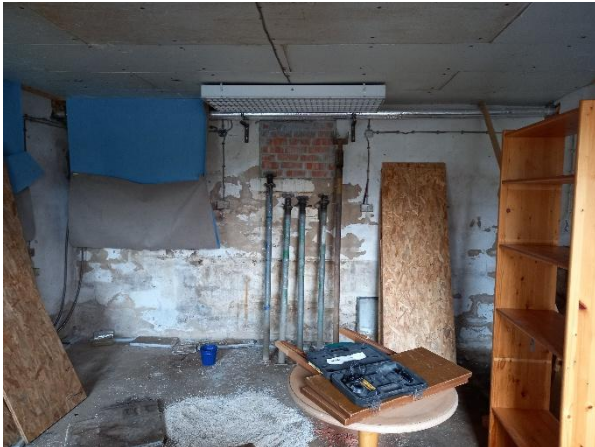
Abb. 10: Innenansicht der Garage
