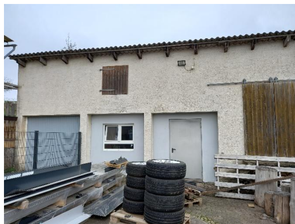
Abb. 9: Garagengebäude mit darüberliegendem Lagerraum
