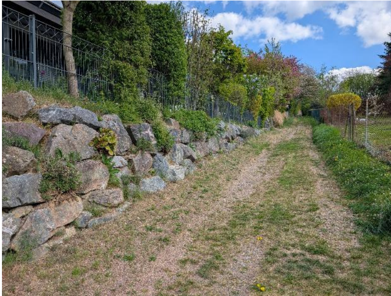
Abbildung 14 Mauer entlang des Zubringers
