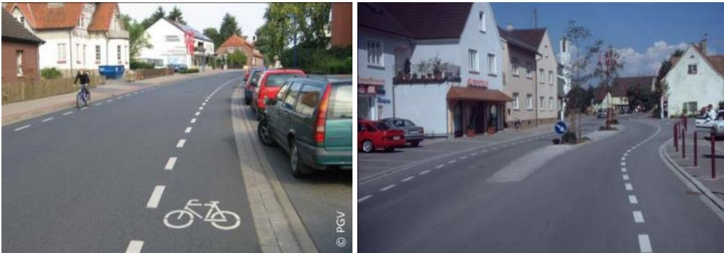
Abbildung 8: Schutzstreifen im Zuge innerörtlicher Hauptverkehrsstraßen [1]
