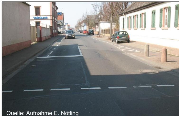
Abbildung 44: Radverkehrsführung am westlichen Knotenpunktsarm L3413
