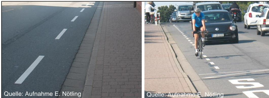
Abbildung 46: Versatz zwischen Asphaltfahrbahn und Pflasterrinne
